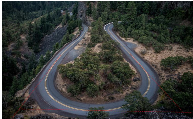
Fig. Un ejemplo de aplicación de las curvas bi-céntricas
