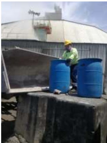
Figura 26. Fotografía del Personal operativo, encargado de la distribución de combustible, actividad: 15. La excavadora llega al punto de encuentro, que es el domo y con ayuda del operario, quien manualmente mueve el tonel, lo coloca finalmente junto a los otros toneles que
