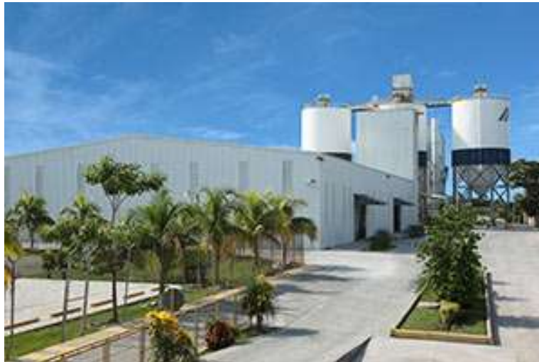
Figura 7. Fotografía de la Planta Arizona, CEMEX, Guatemala.
