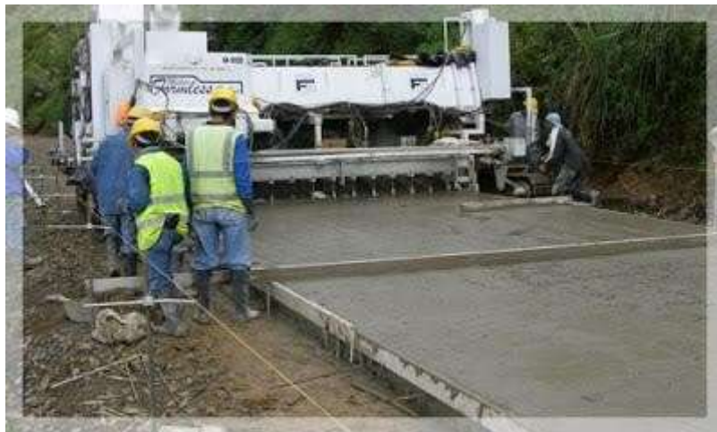
Figura 4 – Carpeta de rodadura
