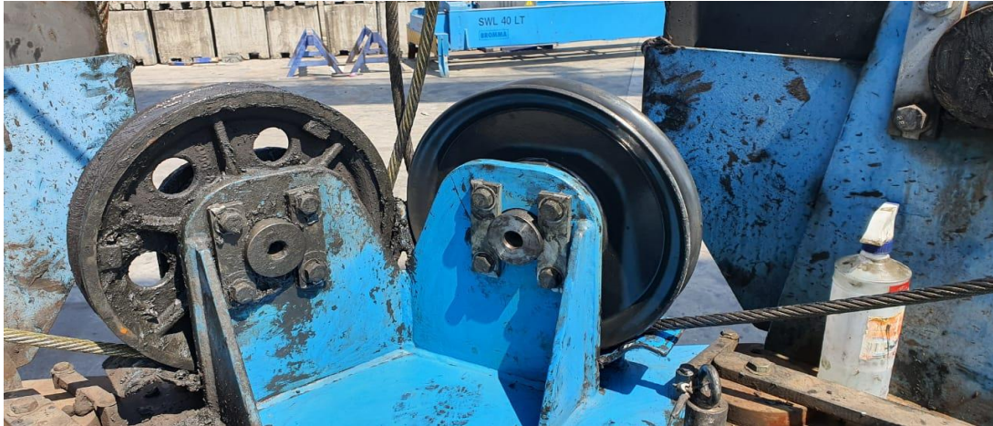
Figura 18. Cambio de cojinetes a sistemas de cables auxiliares de elevación
