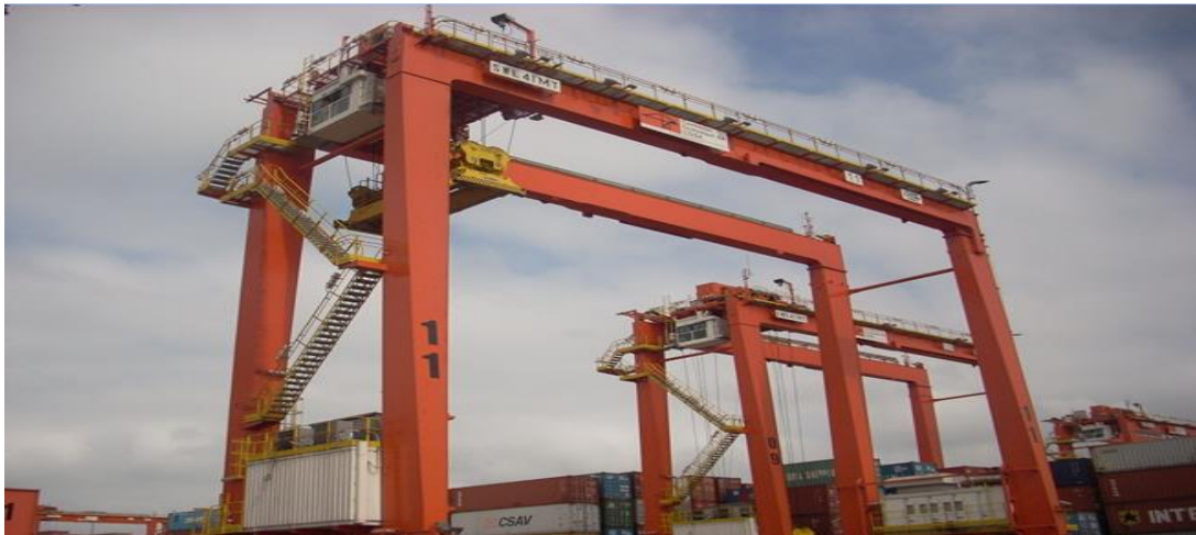
Figura 1. Panorámica de la Grúa Pórtico (RTG)
