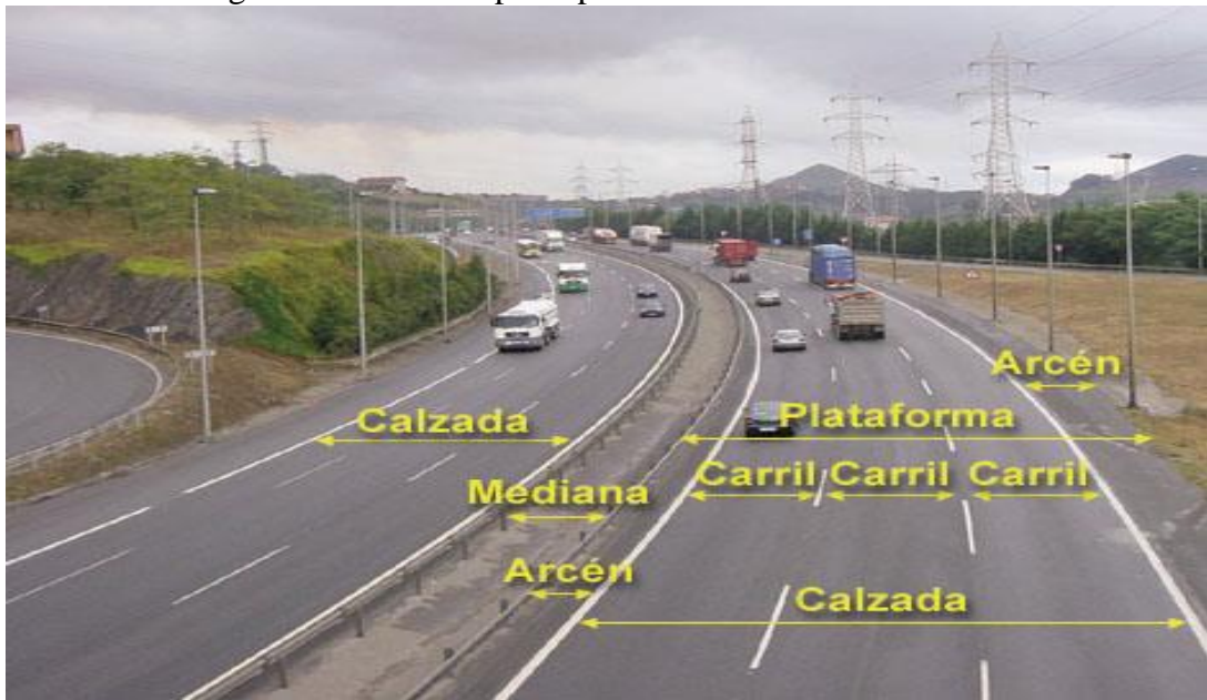
Figura 1. Elementos principales de la infraestructura vial.
