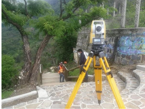
Figura 13: Uso de estacion total en levantamiento topográfico municipio San Juan La Laguna, Sololá.
