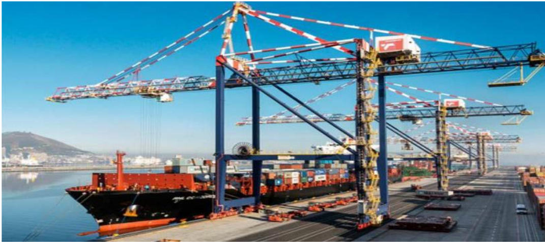
Fotografía 3 Grúas Ship to Shore (STS)
