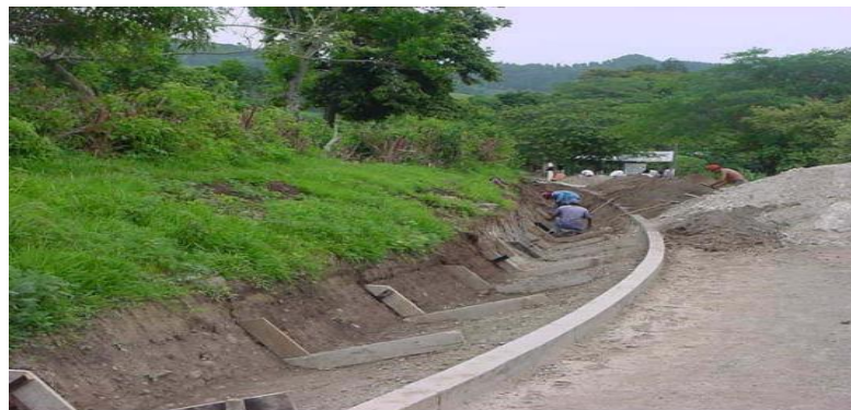
Figura. No. 4 construcción de un drenaje pluvial.
