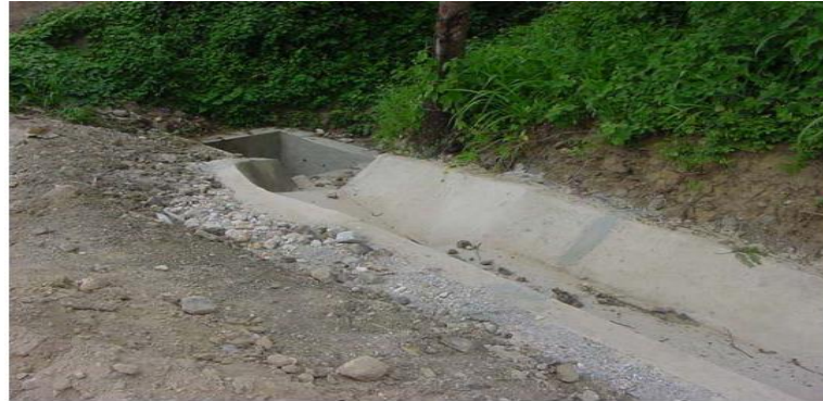
Figura. No. 3 construcción de drenaje con determinada inclinación.
