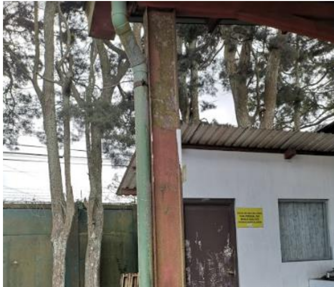
Imagen 16. Estructuras de bodegas.
