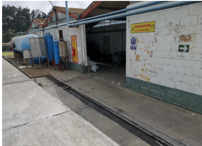
Imagen 9: Fachada de edificio.
