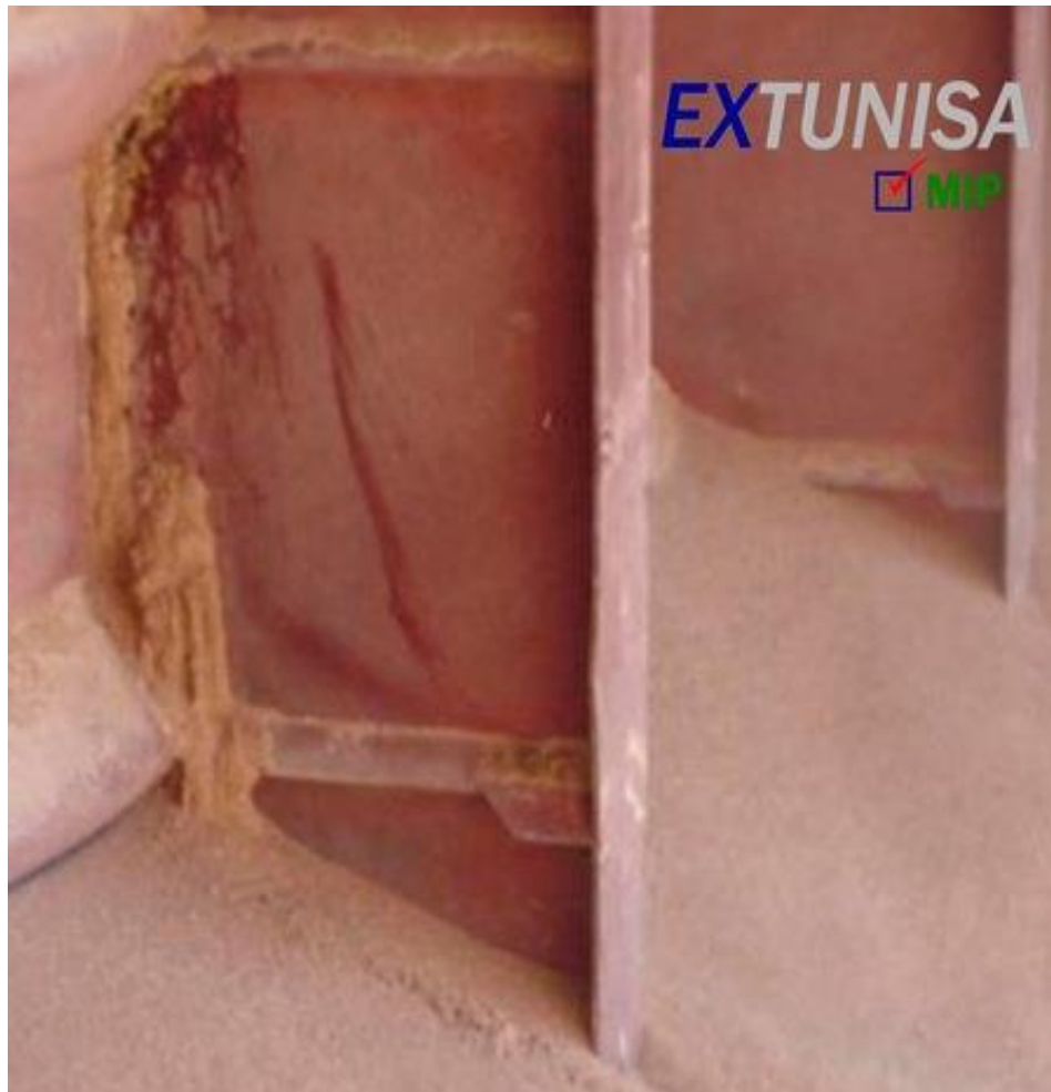
Figura 10 “Muñeco” en pared de bodega
