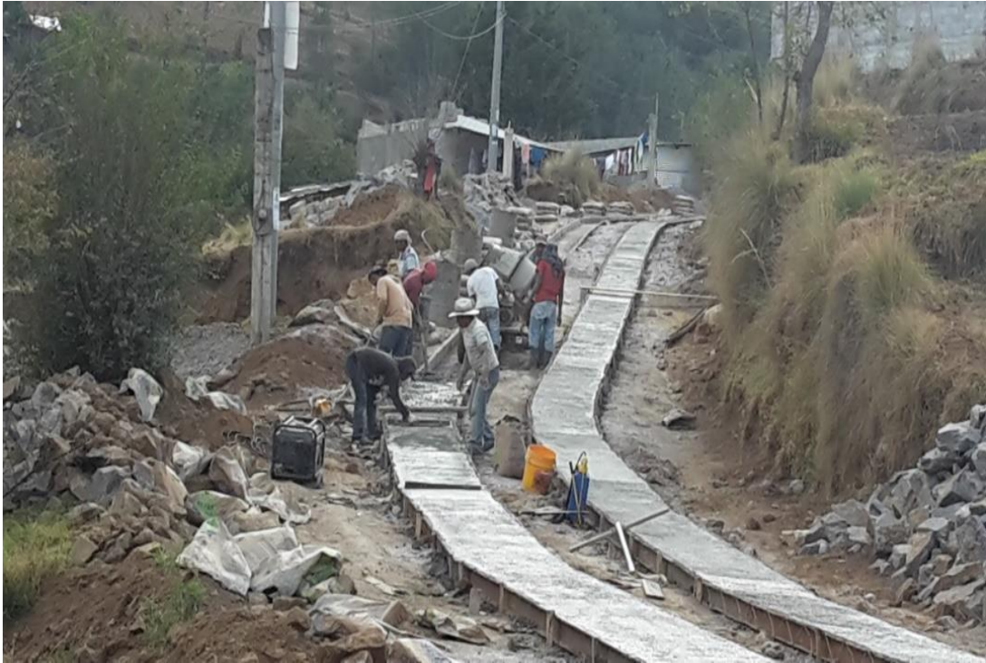
Figura 24: Mejoramiento de empedrado con carrileras de concreto, San Lorenzo, San Marcos.
