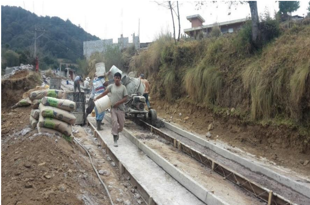
Figura 12: Fundición de carrileras de concreto, San Lorenzo, San Marcos.
