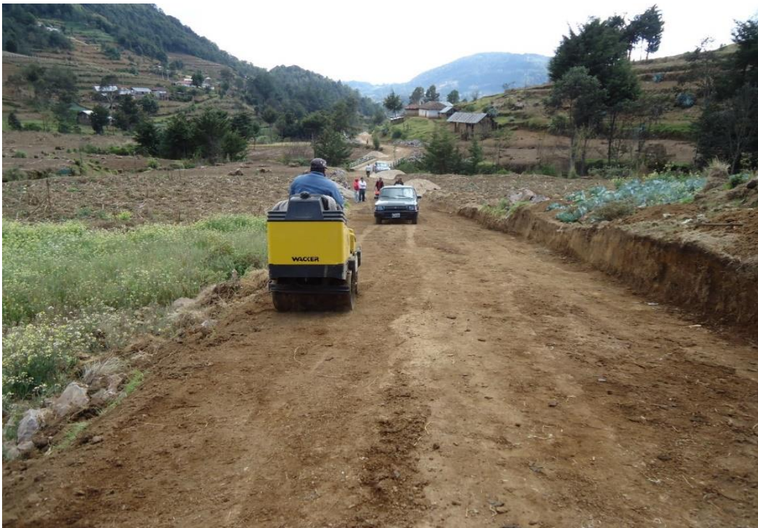
Figura 20: Compactación previa a elaboración de pavimento rígido de concreto, San Miguel, San Marcos.
