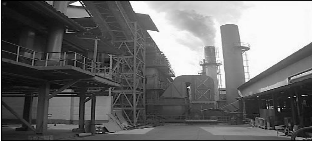
Caldera acuotubular para bagazo de caña
