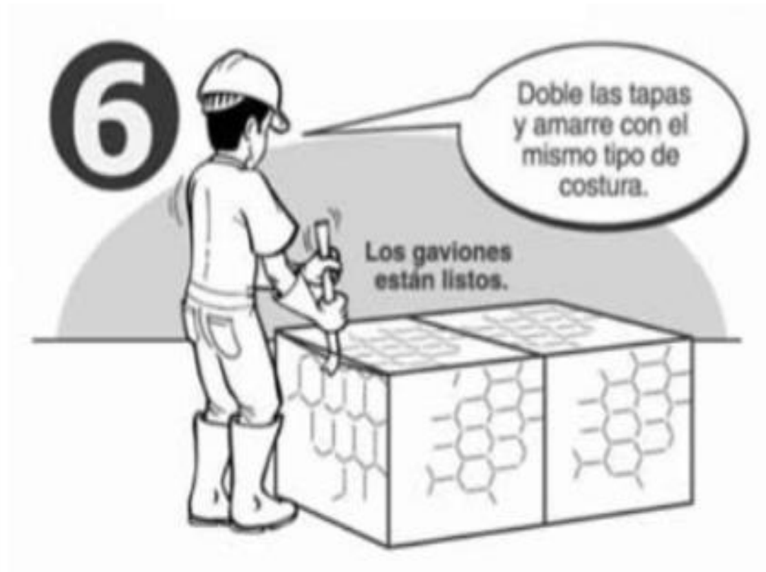
Figura 17. Los gaviones están listos, doble las tapas y amarre con el mismo tipo de costura.
