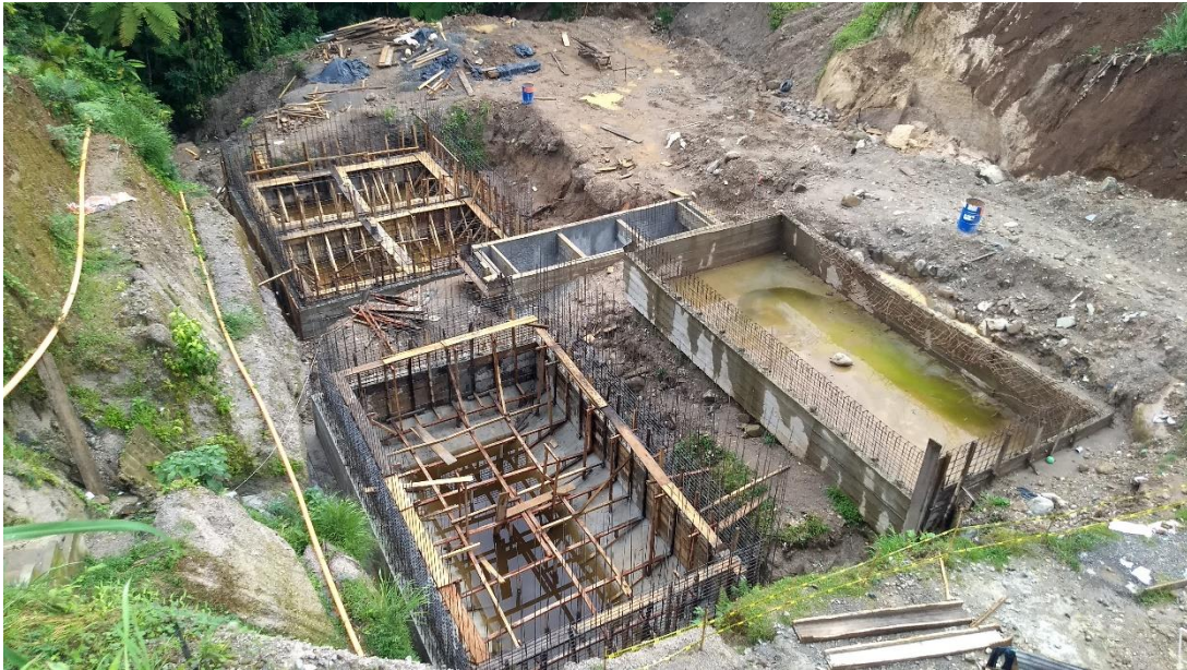
Figura 8: Construcción de planta de tratamiento de aguas residuales
