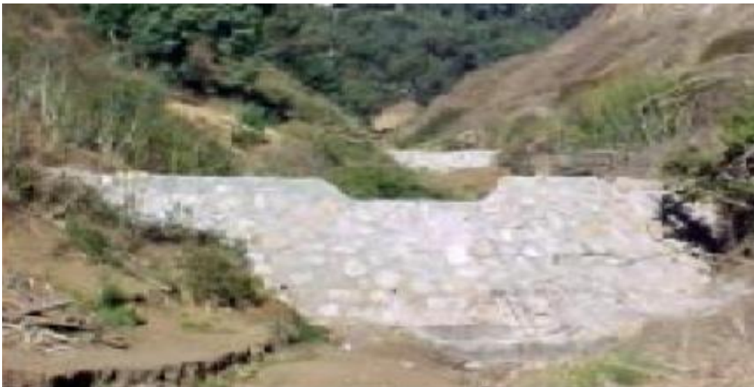
Figura. 11 Dique de piedra con cemento.
