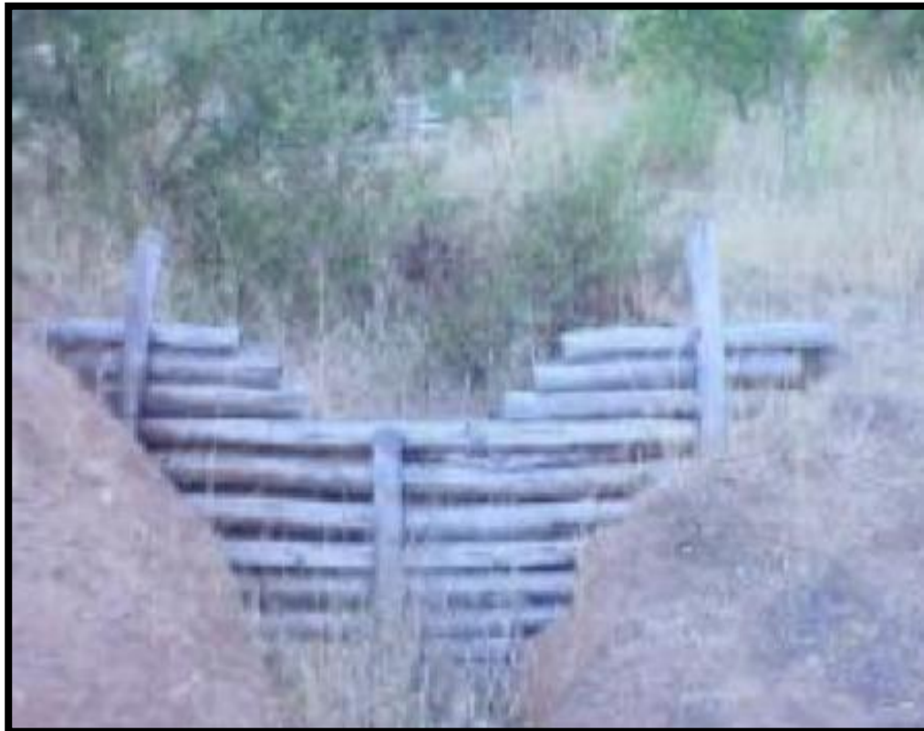
Figura. 12 Dique de postes de impregnados con sacos de tierra
