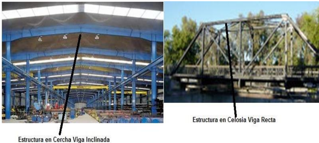
Figura 9 Tipos de estructuras
