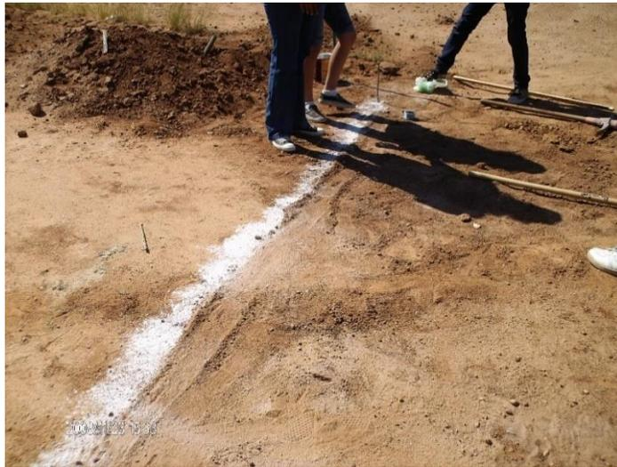
La excavación de la zanja sobre la cual se instalará el sistema de drenaje requerirá de materiales para dicha actividad y la mano de obra de los trabajadores necesarios cuya tarea requerirá 5 días, finalizados estos trabajos se procederá a la instalación de la tubería de 6" y 8", esto requerirá tubería PVC y pegamento para unir cada tubo, posteriormente el relleno de zanja y compactación manual que llevará un plazo de hasta 8 días.
