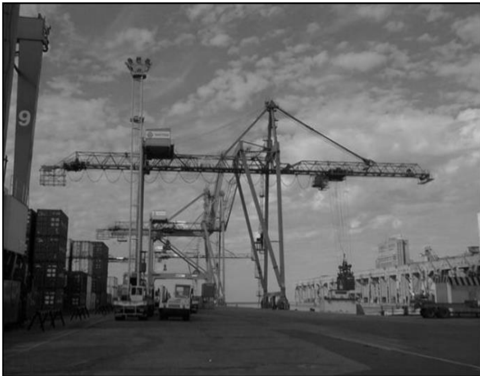
Figura 16. Grúas pórtico de muelle
