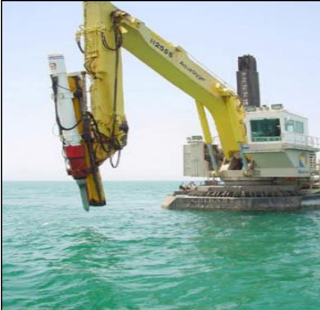
Figura 23. Uso de pilones rompe rocas
