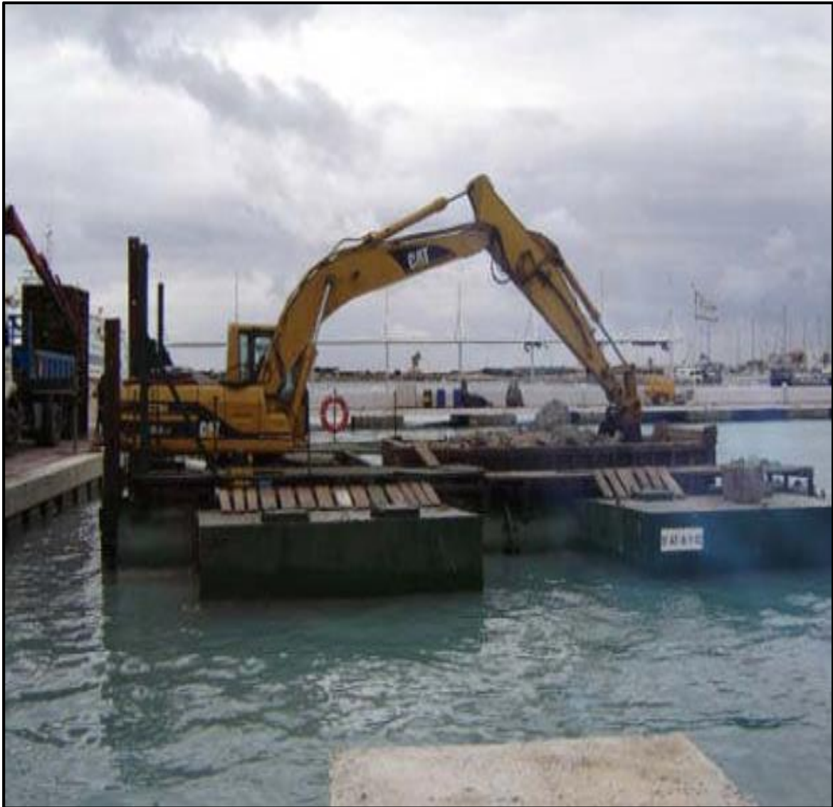
Figura 25. Descarga del gánguil con pala ó dipper con retroexcavación
