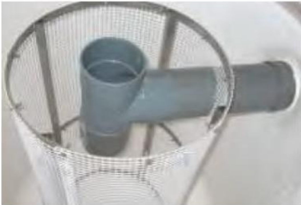
Imagen No. 12 - Tanque de tamizado-trampa de grasas.
