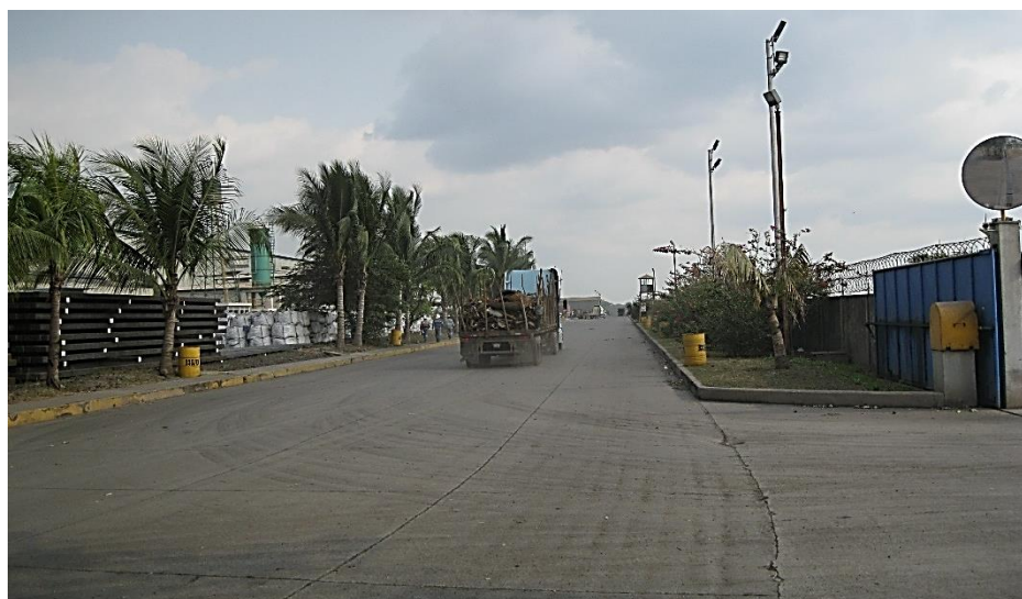
Acceso a patio de chatarra
