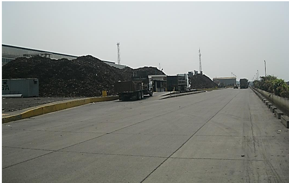
Acceso a patio de chatarra
