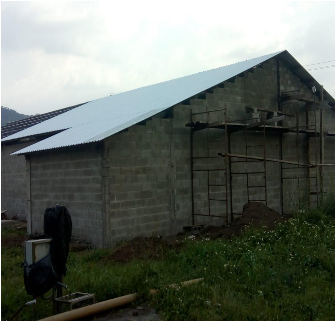
Imagen 12: Cubierta a dos aguas
