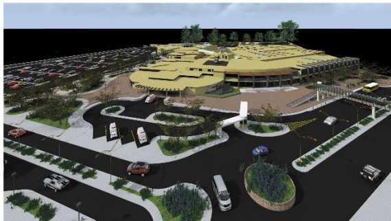
Vista ingreso lado sur
