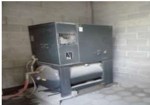
Ilustración 14: Compresor de tornillo.
