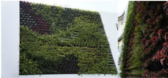
PLAZA DECORISIMA, ZONA 10 DE GUATEMALA UTILIZACIÓN DE CAPA GEOTEXTIL ENLACE DE BOLSA
