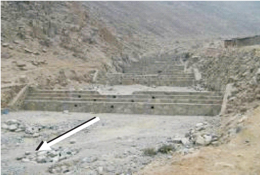
Figura 10. Disipador de energía con diques.
