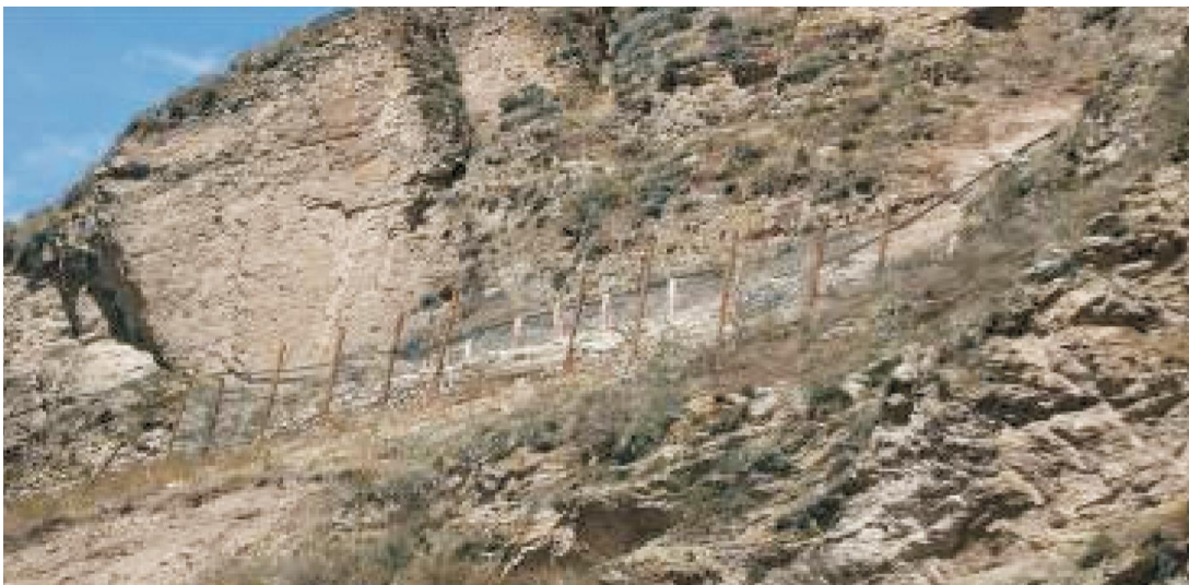
Figura 16. Barreras dinámicas contra derrumbes.
