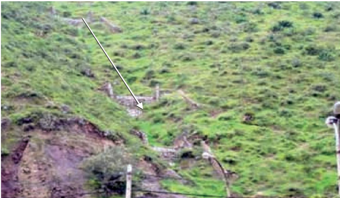
Figura 9. Disipador de energía semi-rústico.
