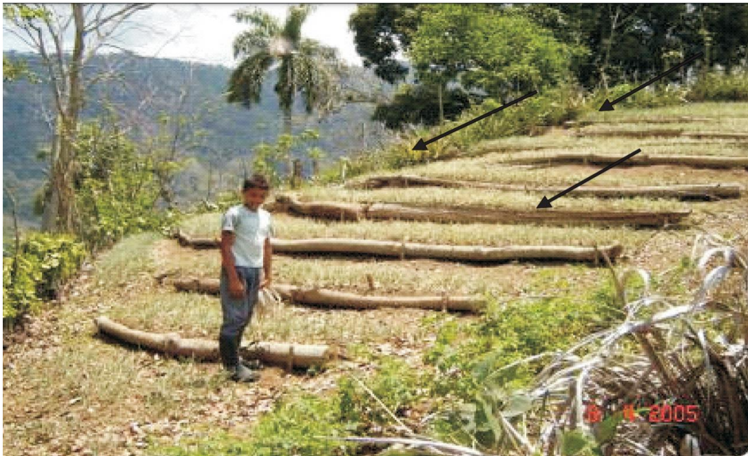
Figura 12. Disipador de energía a base de troncos.
