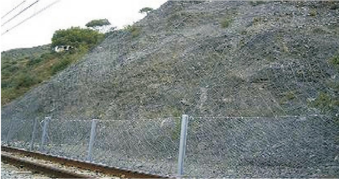
Figura 15. Estructura de estabilización de rocas con malla anclada.
