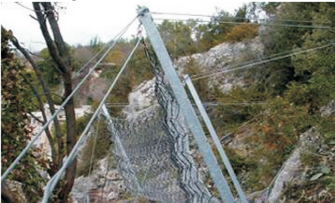
Figura 13. Estructura con malla de acero tensada.
