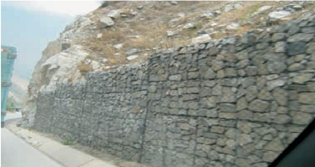
Figura 18. Estructura con gaviones.
