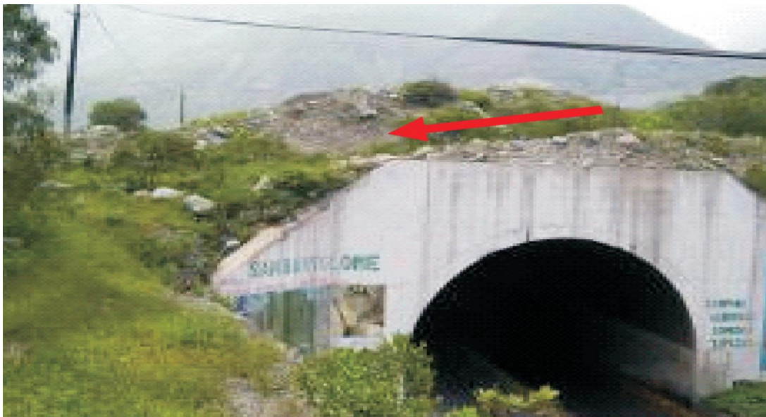
Figura 17. Estructura anti-derrumbes mediante túnel.
