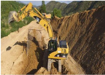
Es la excavación, separación o extracción de tierras de forma manual o mecánica con una excavadora. En cuanto a la excavación puede ser desmonte, vaciado o terraplenado, en este último es la colocación de tierra necesaria para que un terreno alcance el nivel deseado. Los movimientos son soltar y remover, elevar y cargar, distribuir y compactar. (Ideconsa, s.f.)
