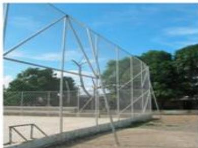
Es necesario colocar una barrera de 3 mts. en todo el perímetro del área para práctica del deporte y 5 mts. detrás de las porterías para evitar la intromisión de vehículos, personas u objetos, pueden construirse columnas en concreto para sostener la malla (Multiestructuras, 2017)
