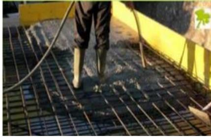
Se refiere a la superficie plana en posición horizontal compuesta de una red armada de metal, amarrada con alambre y rellena de concreto, es utilizada en entrepisos y azoteas. (UNACH, 2013)
