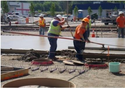
Estructura que permite distribuir el tránsito peatonal o vehicular, puede tener densidad y cotas del terreno especificadas en el diseño, se inicia con la colocación del concreto. (UNACH, 2013)
