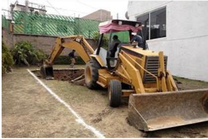
Es limpiar el terreno de cualquier tipo de vegetación que se encuentre en el área, como raíces, troncos y tocones sobre la rasante de construcción, para que posteriormente se pueda nivelar el área de tal manera que tenga una superficie plana. (Homify International, 2018)
