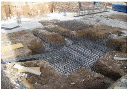
Elementos estructurales para transmitir cargas o elementos apoyados en el suelo, de preferencia los cimientos deben ser cargas al centro. Transmiten compresiones y esfuerzos de rozamiento y adherencia, soportan cargas de tracción y horizontales, lo que puede anclar el terreno al edificio. (Gómez, 2014)
