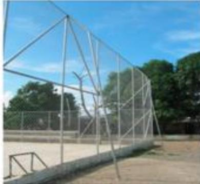
Es necesario colocar una barrera de 3 mts. en todo el perímetro del área para práctica del deporte y 5 mts. detrás de las porterías para evitar la intromisión de vehículos, personas u objetos, pueden construirse columnas en concreto para sostener la malla (World Bank, 2015)
