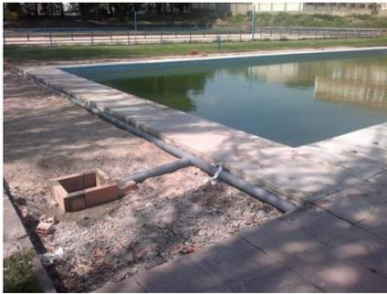
Se propone la instalación de canales para la conducción de agua colectada con tubos PVC de 4", conectadas a cajas en las cunetas o drenajes, en función de la pendiente del techo del polideportivo. (World Bank, 2015)
